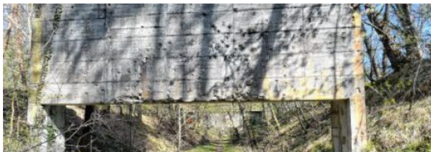
Kugelfänge mit sichtbaren Einschussspuren im Bereich der Langbahnen.
